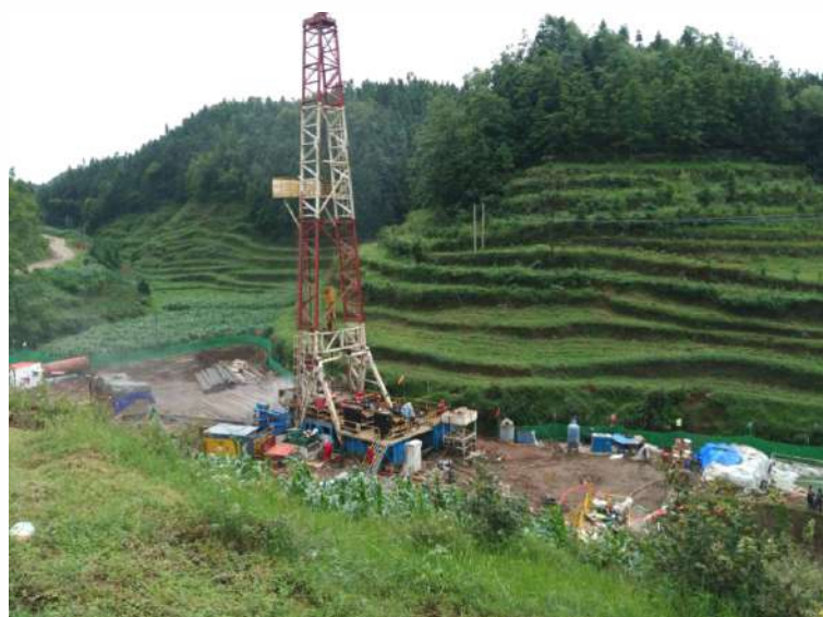
牛1-6-1井台施工现场
