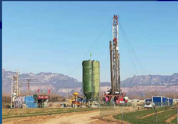
地面区域水害治理工程施工现场图
