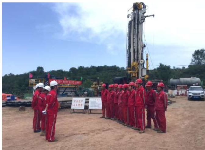
2017ZX-U-01H水平井施工现场
