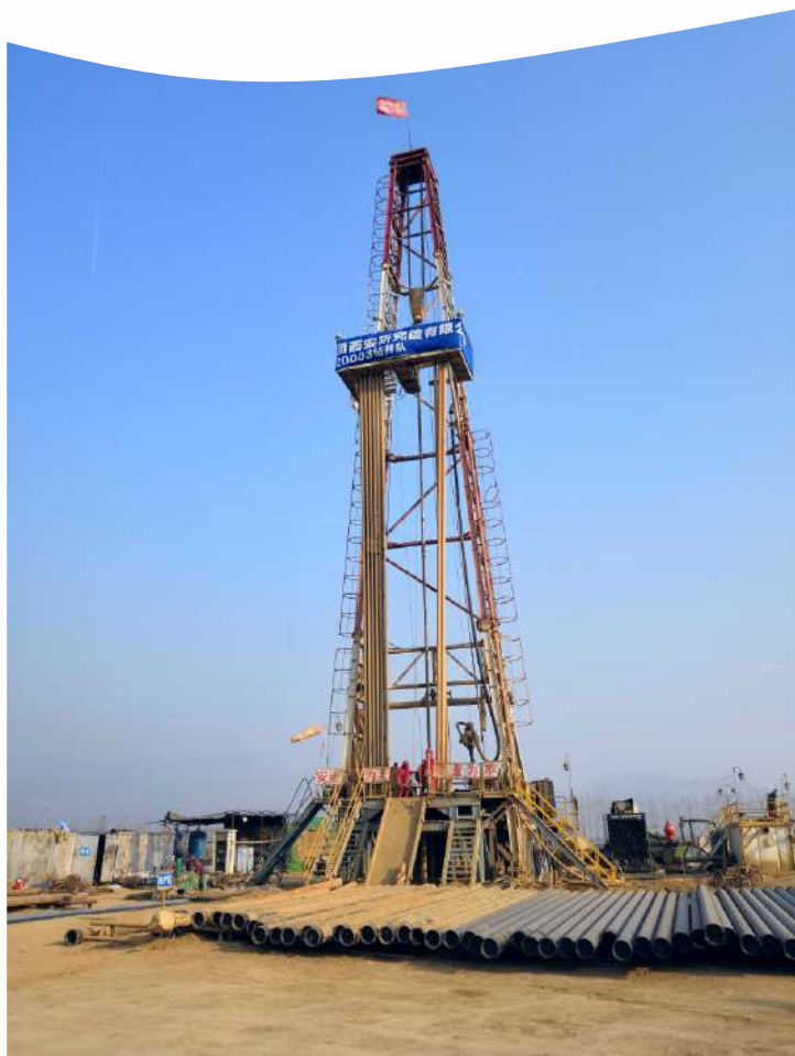
排水井施工现场
