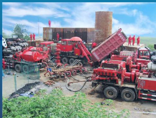
ZX-SH-UM15H井分段压裂施工现场
