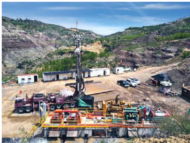
SJ107-2井组施工现场
