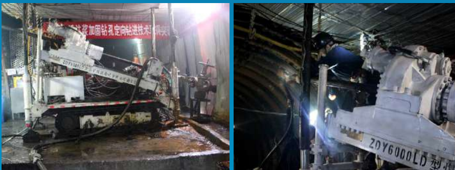
煤层底板注浆加固定向钻孔施工现场
