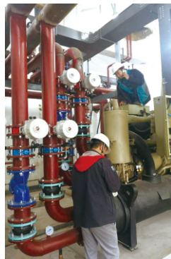
换热机房施工
