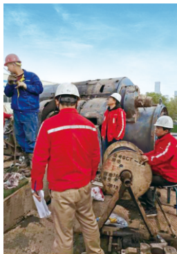
全井段测温光缆安装
