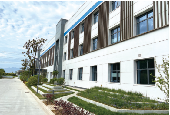
施工区上方路面及绿化
