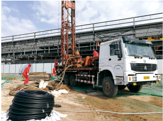
测试孔施工
